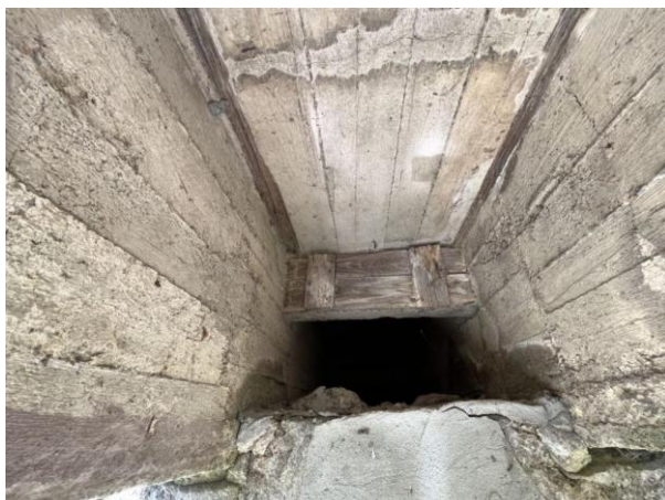
Koncová část NK nad Op1. Potrhaná sanace betonu mezi trámy NK. Zavlhlý úložný práh pod trámy NK. Neodbedněná fasáda příčnicku.
