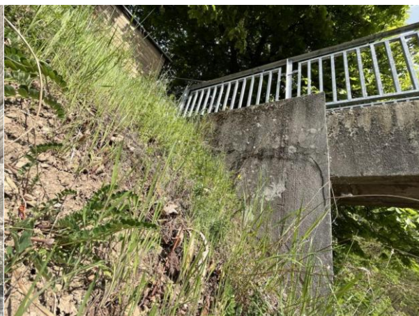
Pravá (návodní) strana Op1. Povrch povrchově degradovaný s lokálně uchycenými mechy. Smyková trhлина v plentovací zídce.
