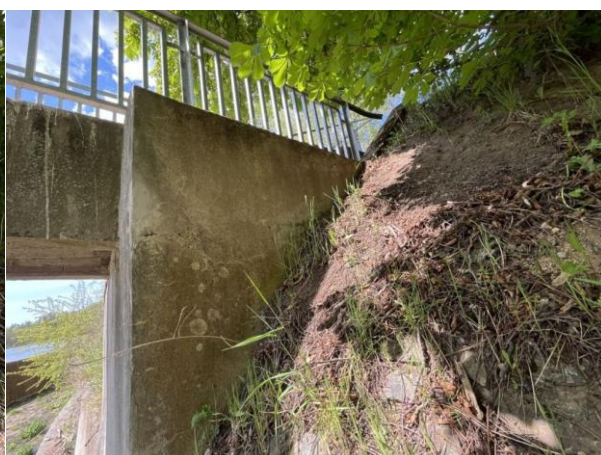
Levá strana Op1. Povrch omítky povrchově degradovaný, opršený, na několika místech s uchyceným lišejníkem. V úrovni paty plentovací zídky smyková trhлина.
