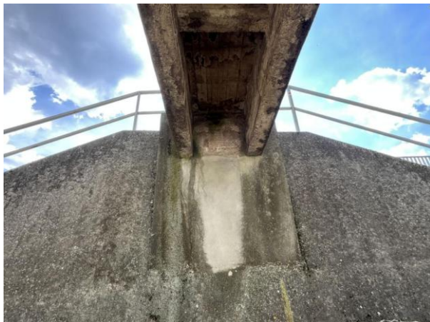
Svislá část vytaženého dřívku Op2. Na čele stopy zatékání okolo trámů NK.
