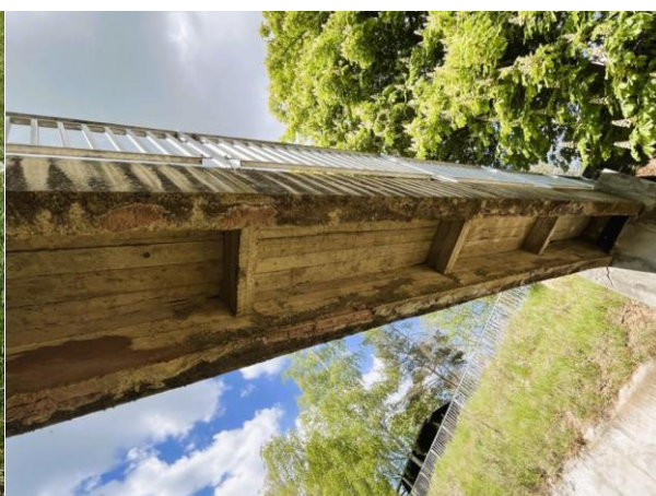
Podhled NK v směru pohledu k Op1. Před 3. mezilehlým příčným vlevo a mezi 3 a 4 příčným vpravo na podhledu NK obnažená výztuž.
