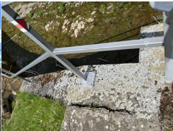
Temeno pravého (návodní) křídla Op2. Uchycení lišejníky a mechy. Na středovém madle zábradlí ojedinělá slabá přítomnost koroze.
