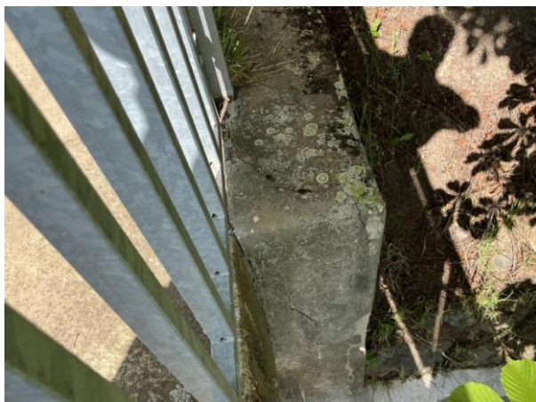
Levá plentovací zídka v pohledu shora. Jeden z možných původců smykové trhliny v plentovací zídce kotvený sloupek zábradlí v trámu NK. Povrch temena plentovací zídky u místa uchycenými lišejníky a meč
