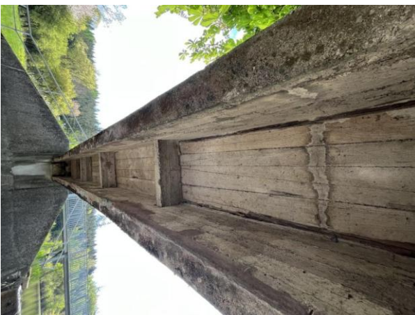
Podhled NK ve směru pohledu od Op1 k Op2. Průsak trhlinou v mostovce mezi 1. a 2. mezilehlým příčnickem.
