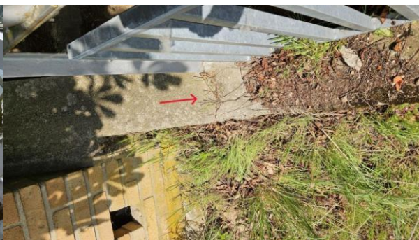
Pravý (návodní) sokl schodiště před začátkem lávky. V místě 1. sloupku zábradlí kotveného do trámu NK příčná trhлина v soklu s uchycenou vegetací.
