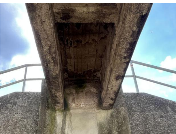
Podhled NK mezi 6. (posledním) mezilehlým příčnickem a vetknutím NK do Op2. Na podhledu mostovky mapy průsaků primárně místech příčných trhlín.
