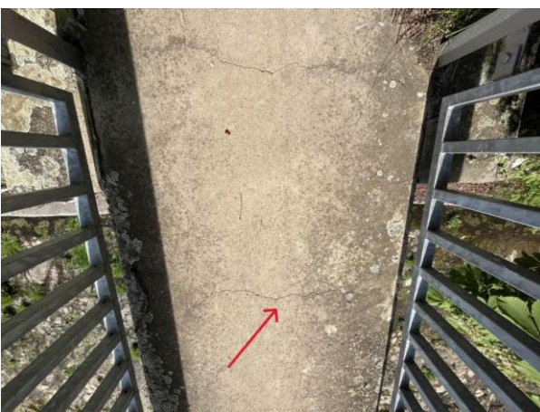
Shora označená trhlina s průsakem mezi 1. a 2. příčnickem
