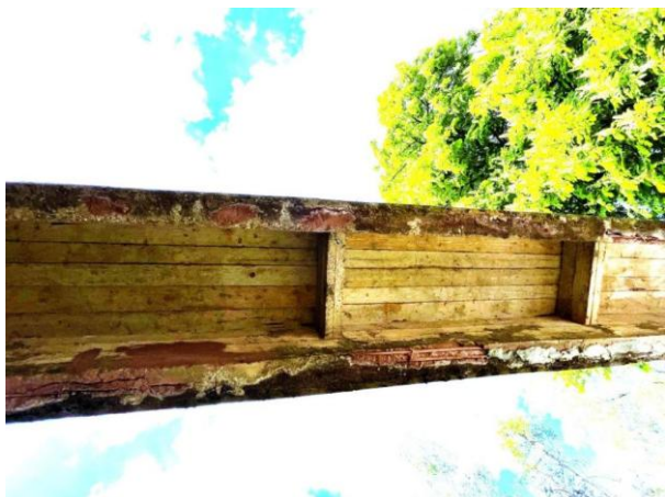
Podhled NK v místě 3. a 4. příčnicku. Na foto vlevo na návodní trámu patrná separace krycí vrstvy výztuže. Na podhledu trámů separace jejich dřívější sanace.
