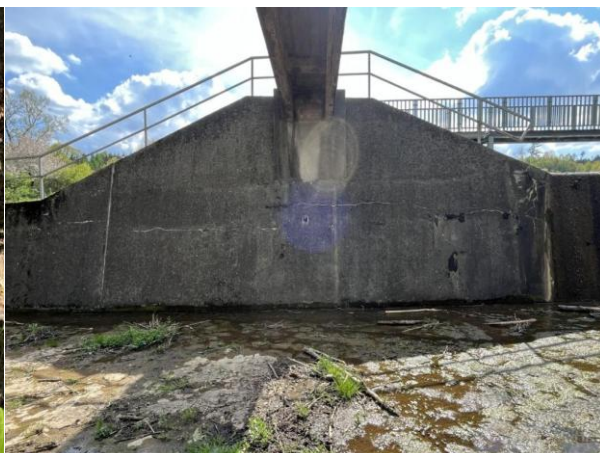
Op2 (pravobřežní). Omítka betonu Op povrchově degradovaná s několika vodorovnými nebo nepravidelnými trhlinami (vpravo u přepadu).
