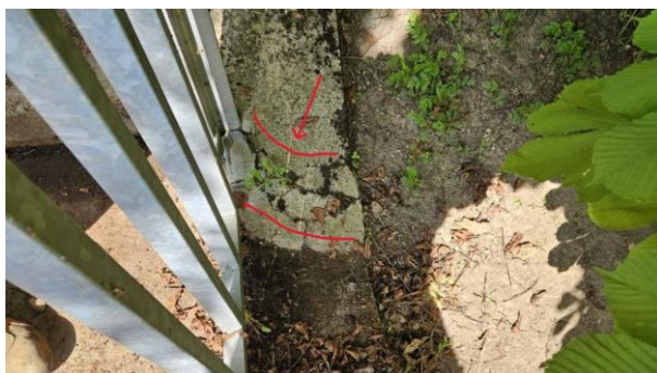
Levý sokl schodiště. V místě 1. sloupku zábradlí kotveného do trámu NK příčné nepravidelné trhliny v soklu.
