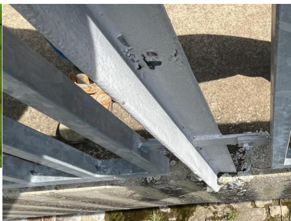
3. sloupek zábradlí na pravé straně lávky. Lokální prorucha PKO.
