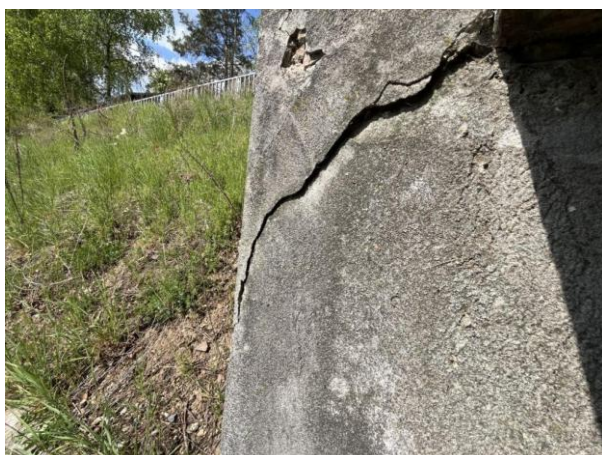
Detail smykové trhliny na čele Op1 v patě plentovací zídky vpravo.
